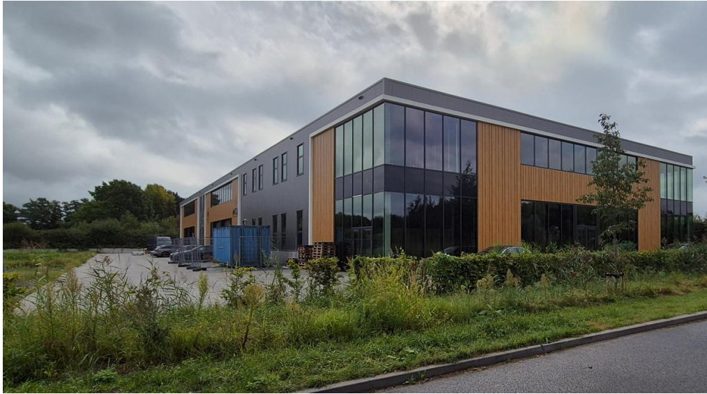
figuur 10 Foto bedrijfsverzamelgebouw noord- en westzijde
