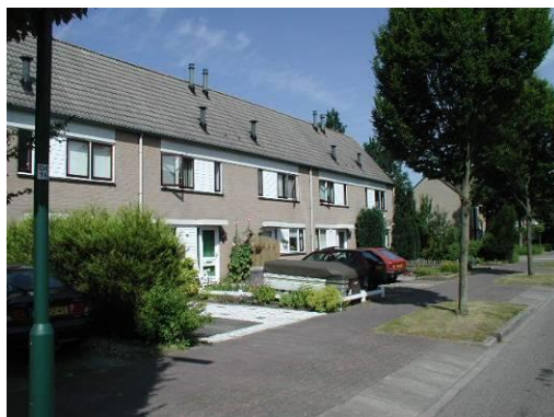
De woningen staan met de kap evenwijdig aan de weg
