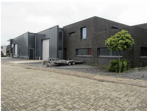
Bedrijfspannd met gevelgeleding
