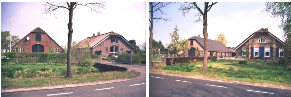
Hallenhuisboerderijen aan de Leusbroekerweg
