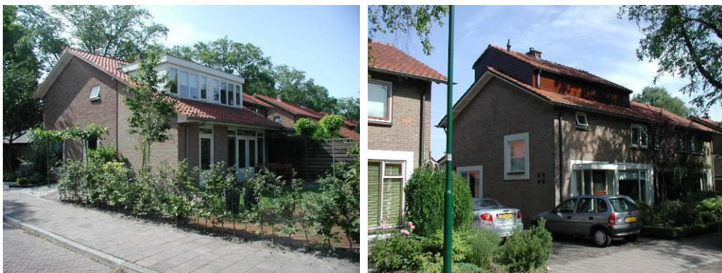
Voorbeeld van een plat afgedekte dakkapel op een woning met uitbouw Voorbeeld van een dakopbouw
