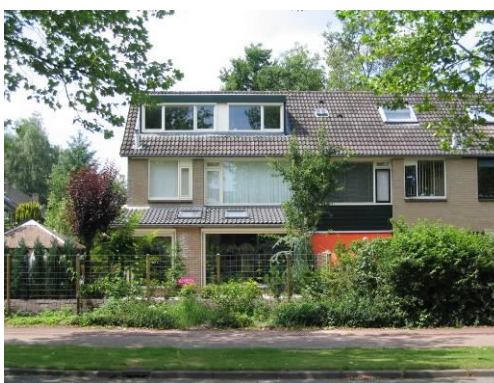
Aan de achterzijde zijn woningen soms uitgebreid met uitbouwen en dakkapellen
