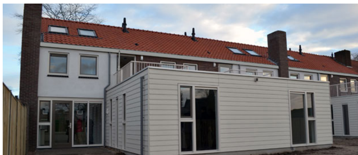
Bestaande woning opdelen in boven- en benedenwoning - Deurne.
