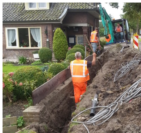
Aanleg drukriolering Arnhemseweg
