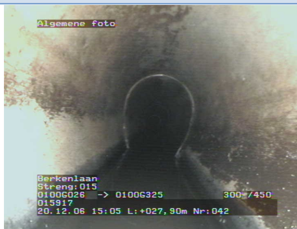
Rioolinspectie met een robotcamera
