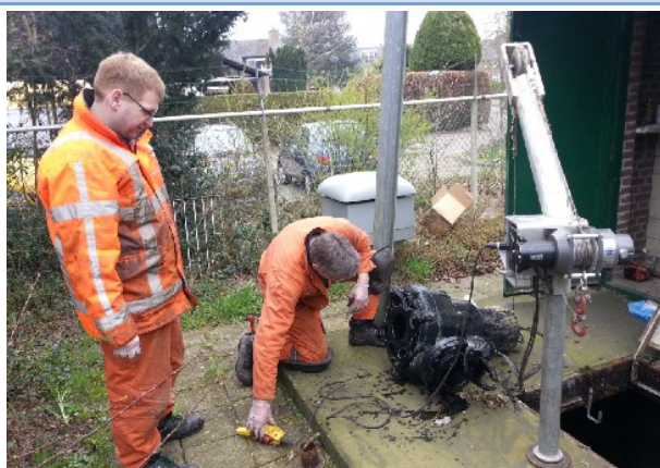
Onderhoud rioolgemaal Leusden-Zuid
