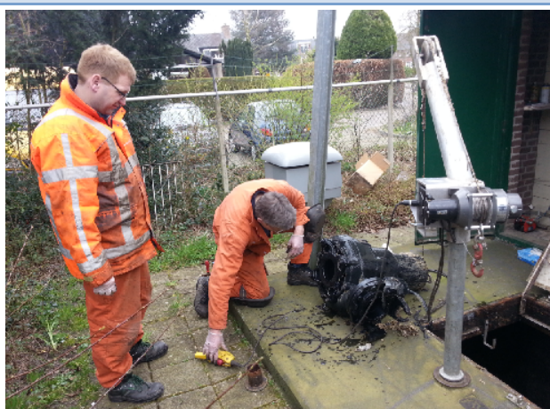
Figuur 25: Onderhoud rioolgemaal Leusden-Zuid
