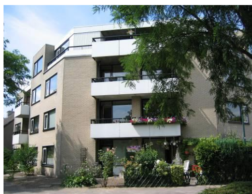
Appartementencomplexen, bestaand uit vier bouwlagen
