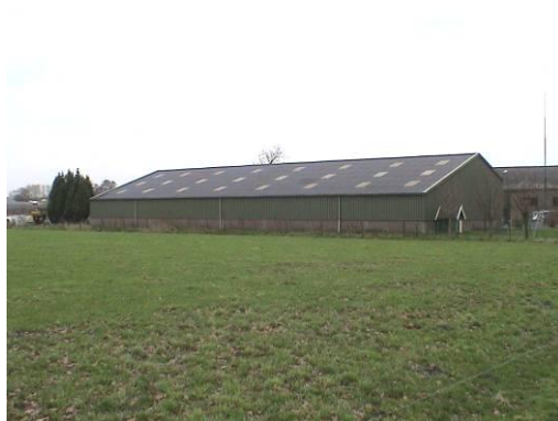
Bedrijfsschuur aan de Laapeerseweg
