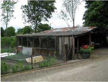
Foto 4: Bijgebouwtje met asbestverdachte golfplaten.
