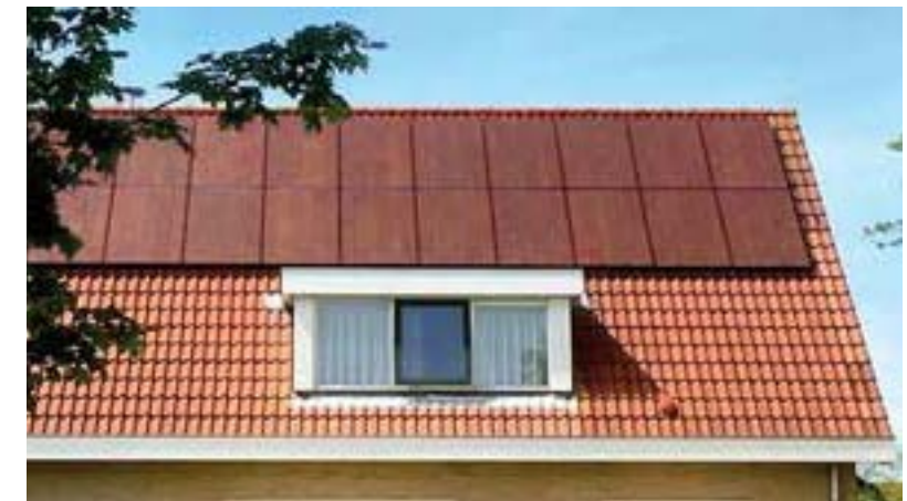
Zwarte en rode PV-panelen. Foto: todoensolar.com
