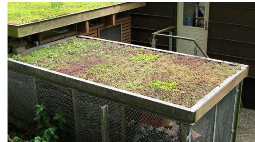
Een voorbeeld van een groen dak op een berging.
