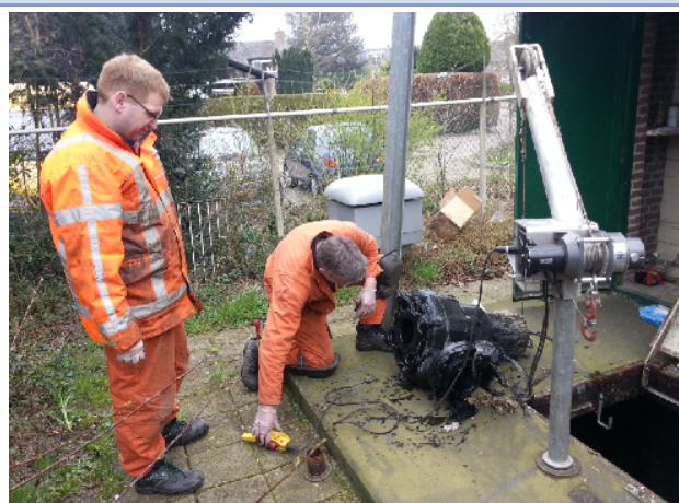
Figuur 25: Onderhoud rioolgemaal Leusden-Zuid
