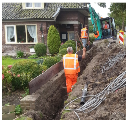
Figuur 13: aanleg drukriolering Arnhemse weg
