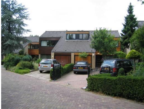
Deze twee-onder-één-kap woningen staan enigszins gedraaid ten opzichte van de openbare weg. De kap loopt door tot op de garage
