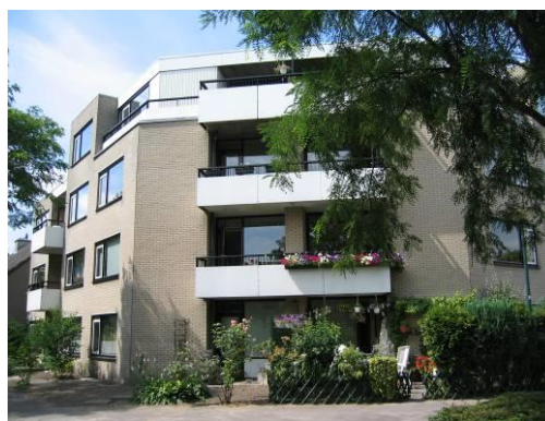
Appartementencomplexen, bestaand uit vier bouwlagen
