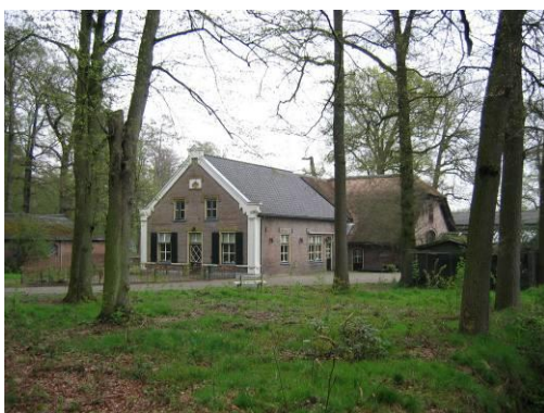
"Wellom" aan de Treekerweg/Heetvelderweg
