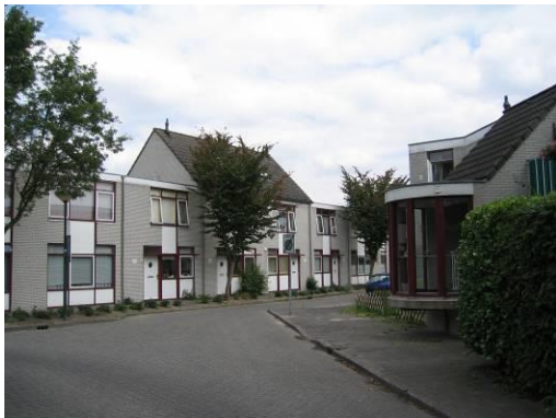
Woningen rondom Leeuwenburg met overwegend een plat dak
