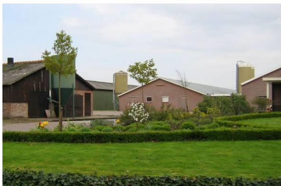
Agrarisch complex aan de Lange Steeg
