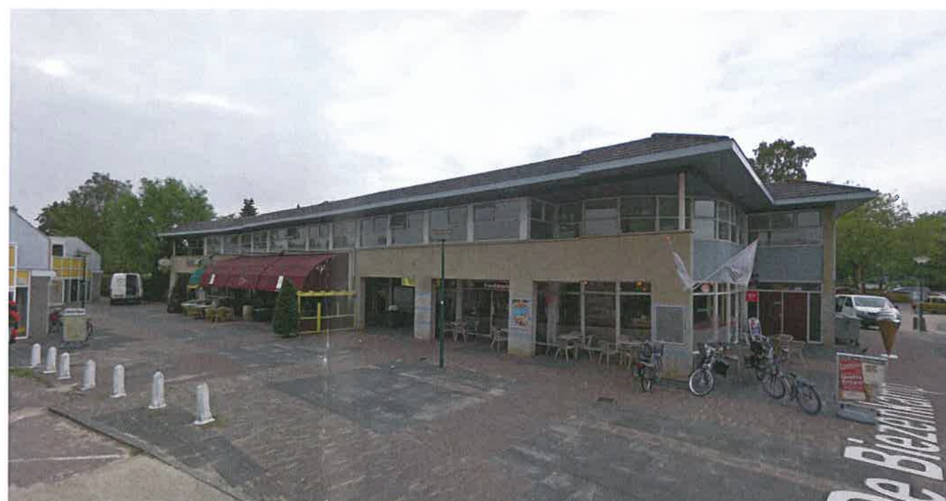
Het bestaande gebouw, zorgvuldig ontworpen met een karakteristieke horizontale geleding
