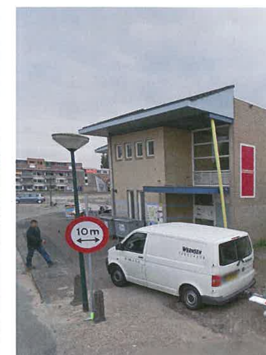
Blinde zijgevel maakt het gebouw niet "af"
