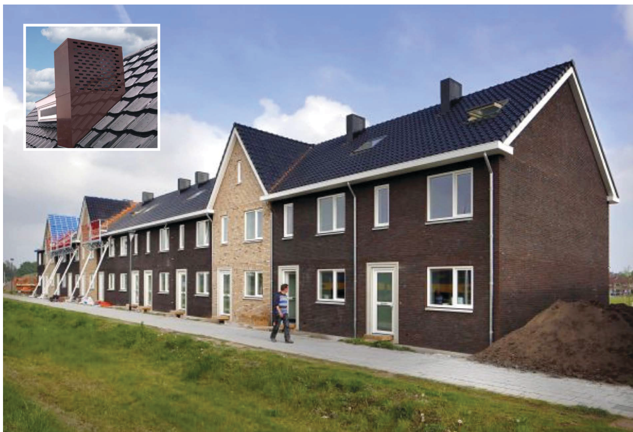
Figuur 6: Een lucht-waterwarmtepomp uitgevoerd als 'schoorsteen'.
