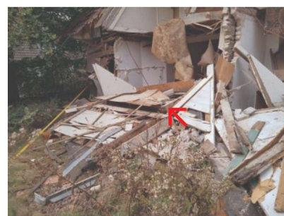
foto: afdichting - gevels
