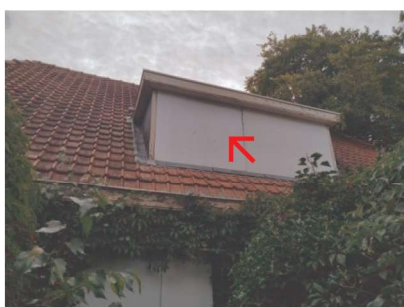
foto: afdichting - gevels
