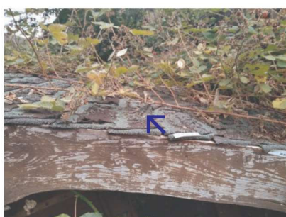
foto: dakbedekking - schuur achtertuin
