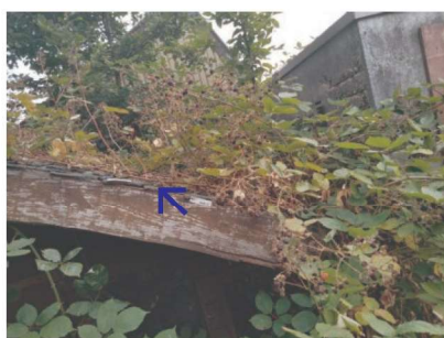
foto: dakbedekking - schuur achtertuin
