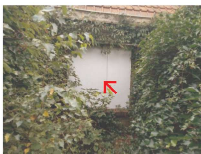
foto: afdichting - gevels
