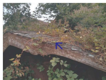
foto: dakbedekking - schuur achtertuin
