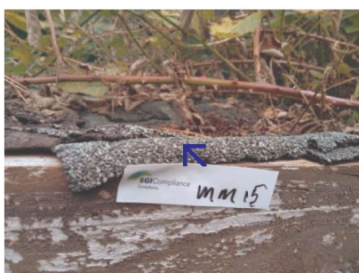
foto: dakbedekking - schuur achtertuin
