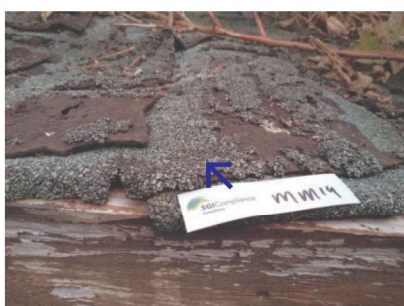
foto: dakbedekking - schuur achtertuin
