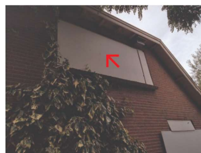
foto: afdichting - gevels
