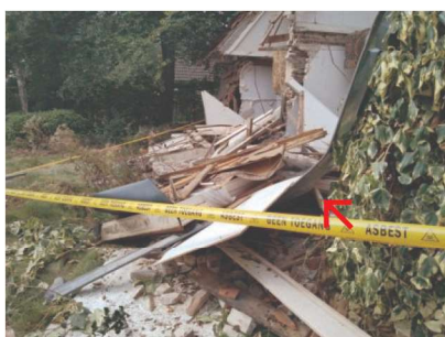
foto: afdichting - gevels
