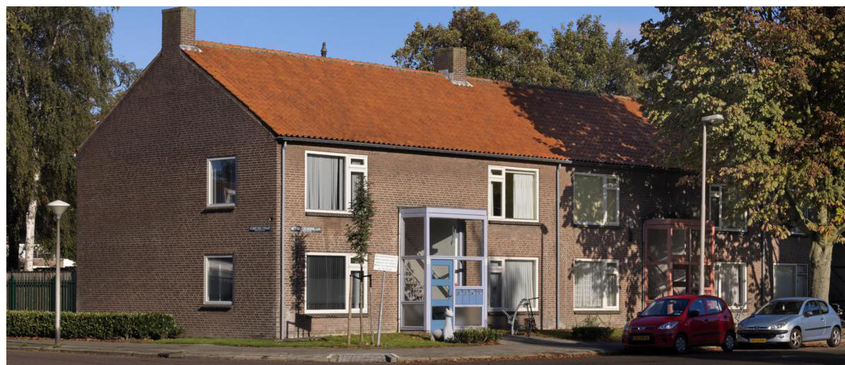
Woningen samenvoegen en verdelen in meerdere appartementen - Eindhoven.
